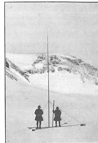
Fig. 20. Bambuställning för uppmätning af snölagrets tjocklek och ackumulationsområdets rörelsehastighet. På Luleavaggeglacieren vid 1 540 m. ö. h.
