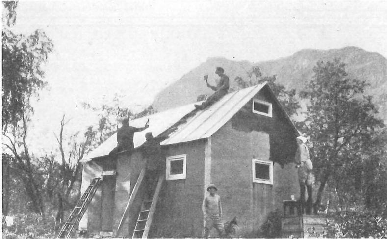
Fig. 25. Auflegen eines neuen, gefalzten Daches auf das alte, genagelte sowie andere Reparaturen an der Skärkashütte. Verf. phot. 6. Aug. 1923.
