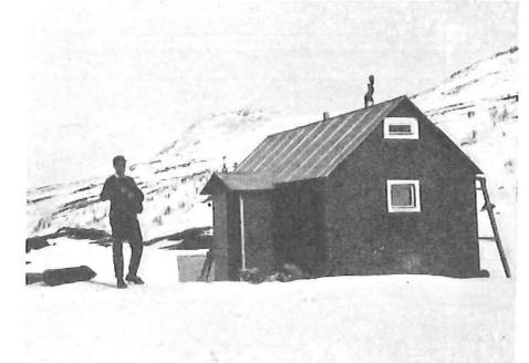
Fig. 15. Die Tjågnorishütte. Rechts eine Dachröhre, die das Anwachsen eines an der Nordseite wahrscheinlich befindlichen Palses verhindern soll. Fenster vorne mit Luken-deckel überdeckt.
